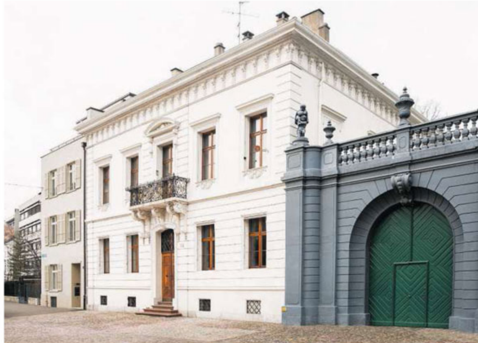
Das repräsentative Haus am Petersplatz 12 gehört neu der Krebsliga beider Basel. (Basel, 17. Februar 2016)
